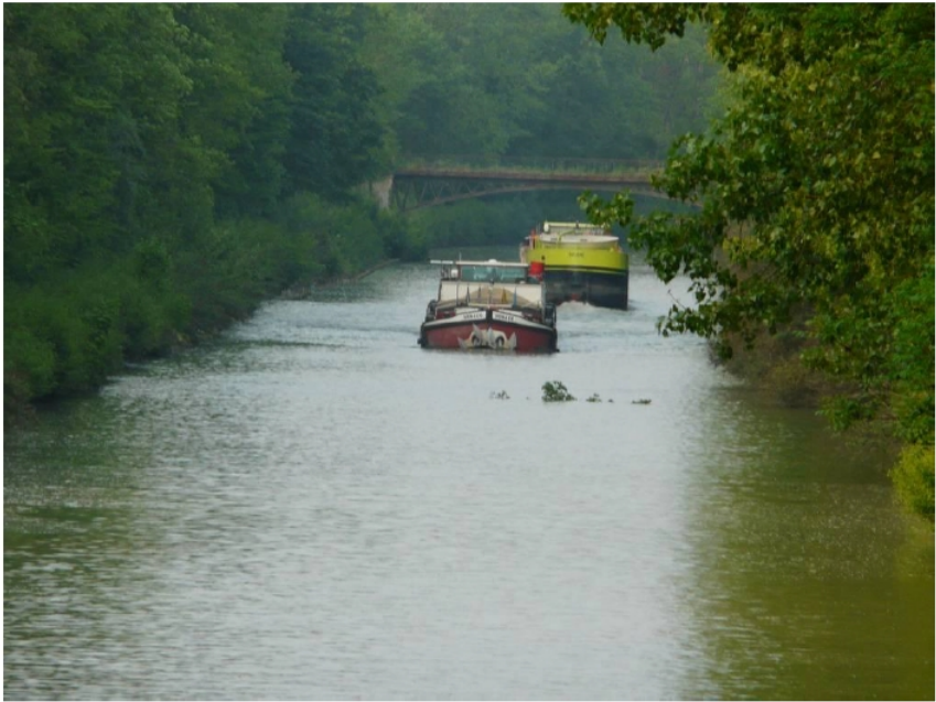
Figure 5.6.3.1-1 : Parc de la Haute Ile - Le Canal de Chelles
