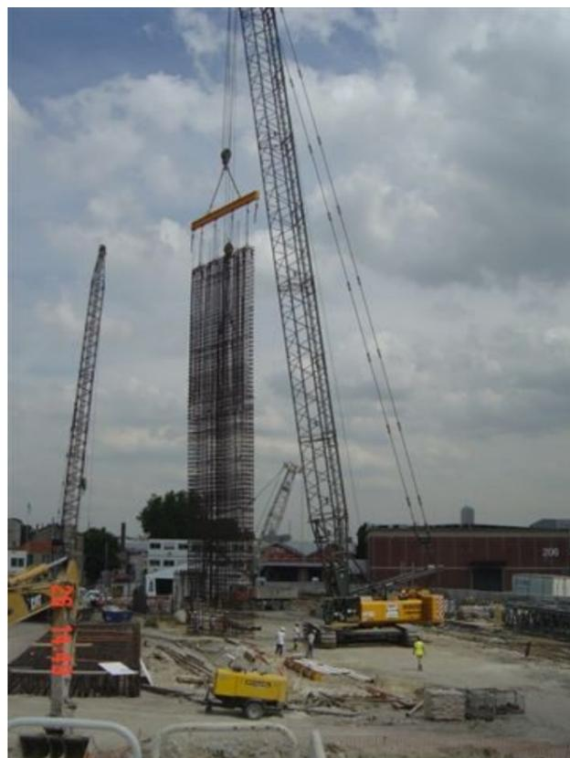
Figure 10 : Mise en place d'une cage d'armatures dans un panneau de paroi moulée
