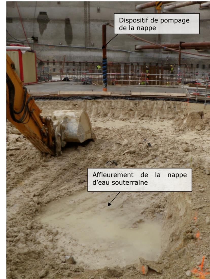
Figure 5 : Nappe d'eau souterraine affleurant lors de travaux de terrassement
