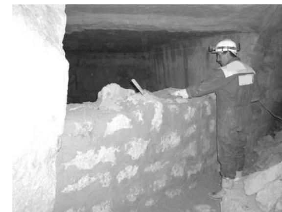
Figure 3 : Mise en place d'un mur masque dans une ancienne carrière souterraine avant injection de la carrière
