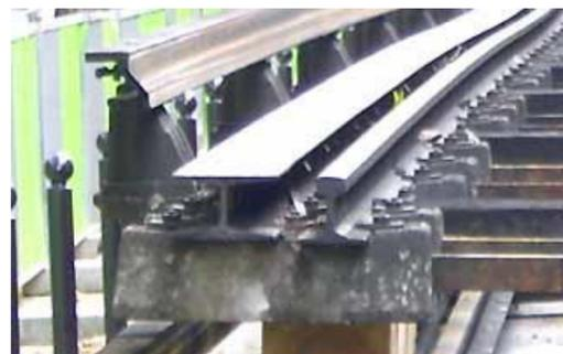
Figure 86 : Détail d'un rail, piste et roulement et barre de guidage montés sur blochet.
