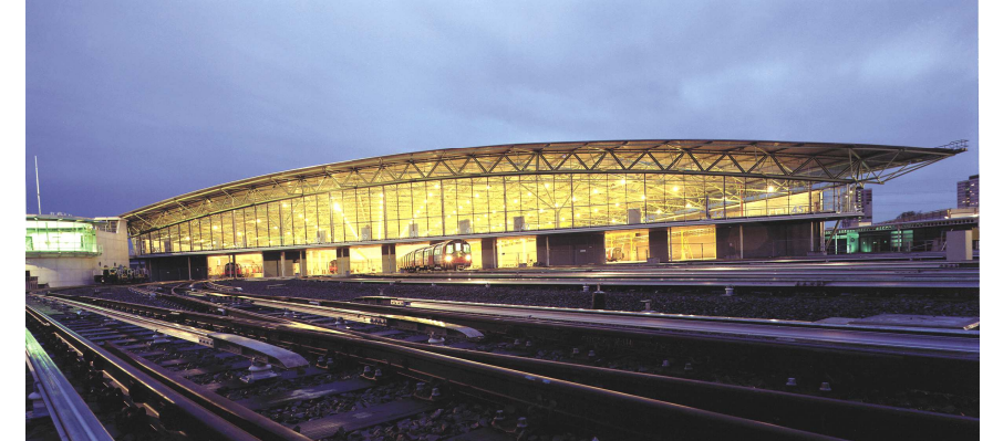
Figure 16 : Site de maintenance du métro de Londres, Stratford (architecte : WilkinsonEyre)
